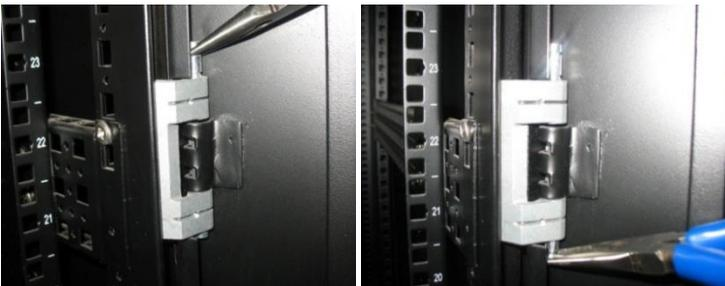
柜门的安装与拆卸步骤相反，请参照上述方法操作即可。
